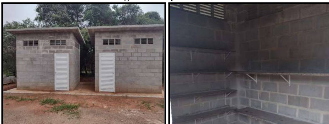
Figura 2 - Depósito de Resíduos
