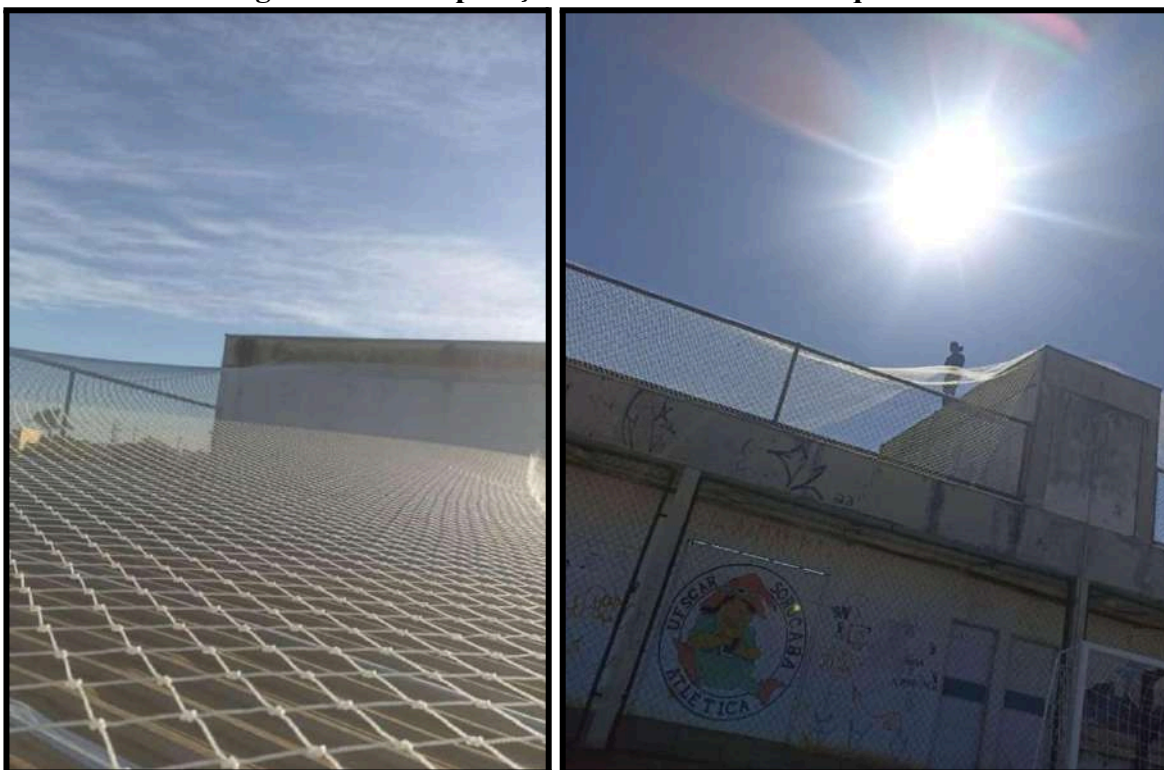
Figura 10 - Recuperação do telhado e tela da quadra.
