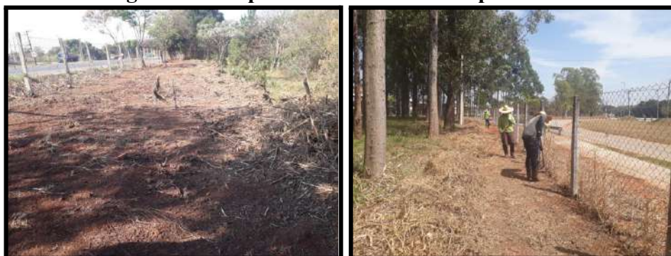
Figura 9 - Limpeza do acesso a futura portaria 2
