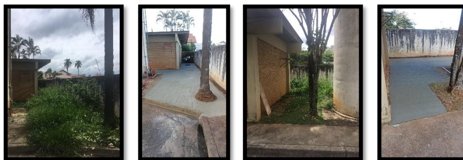
Figura 11 - Antes e depois do cimentado no NTEC.
